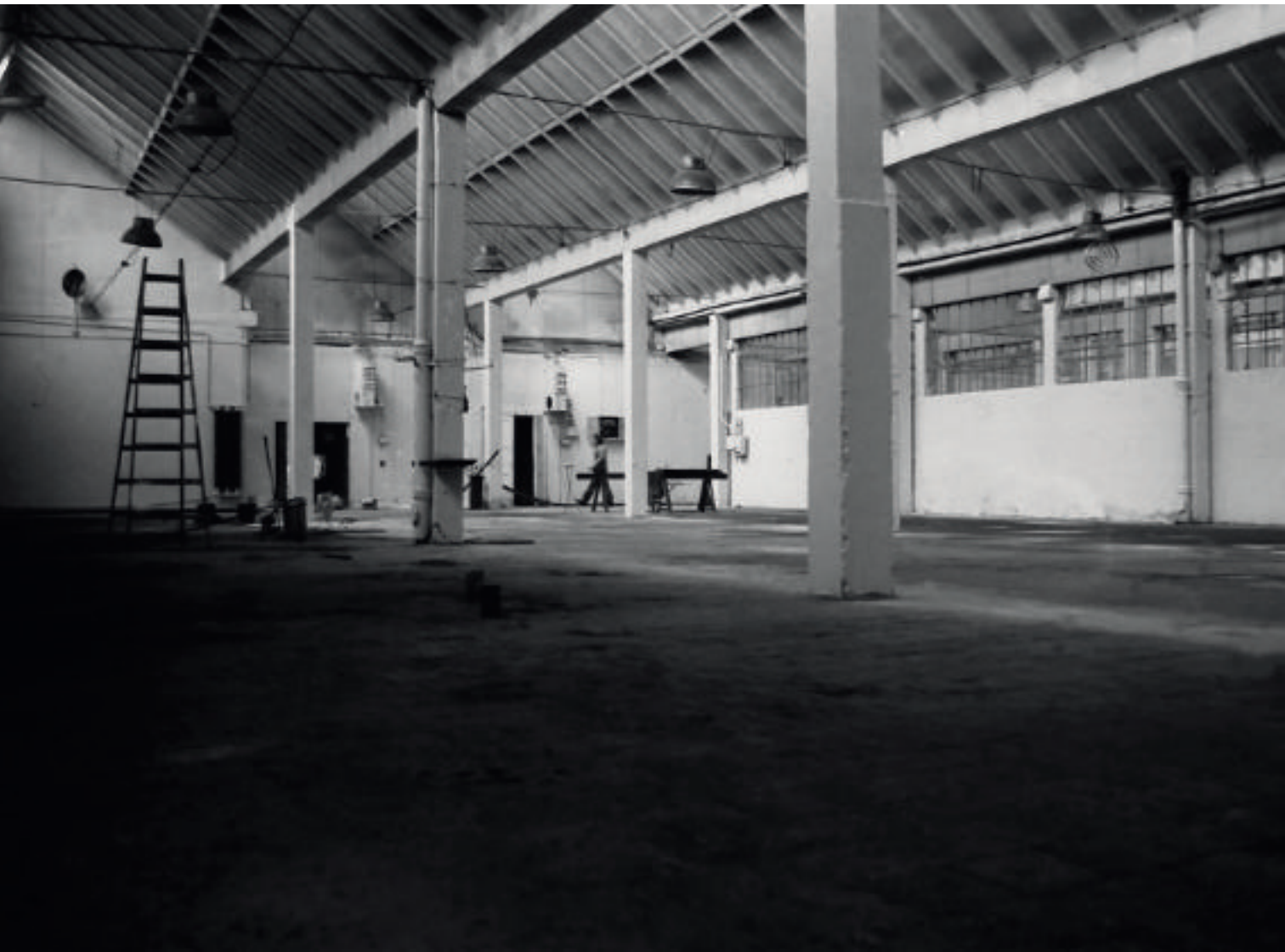
Wnętrze hali Budremu Budrem hall interior
